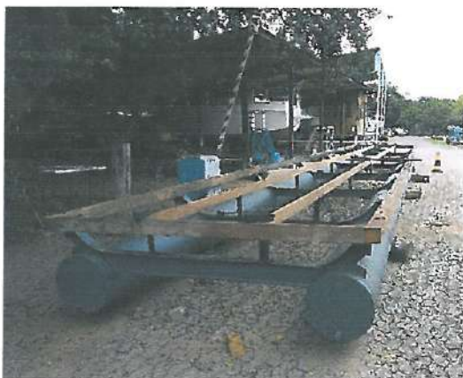
Foi fabricado um novo trapiche flutuante.
