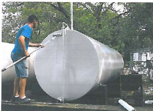
Tanques do ponto de abastecimento receberam nova pintura.
