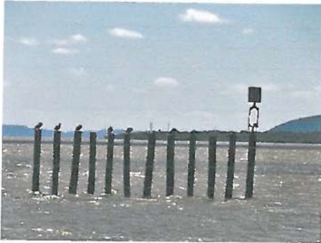
Colocação de estacas nos molhes oeste, com sinalização.
