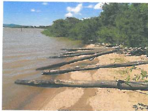
Estacas prontas para serem fixadas nos molhes leste.
