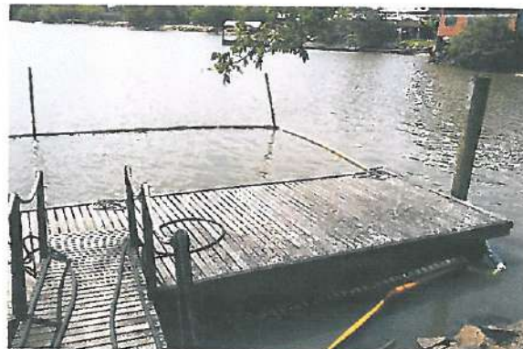
Barreira de contenção igualmente foi revisada para cumprir seu papel em caso de vazamentos.
