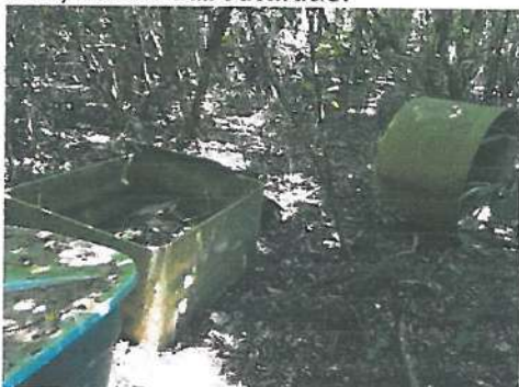
Tanques de água antigos foram removidos da ilha.
